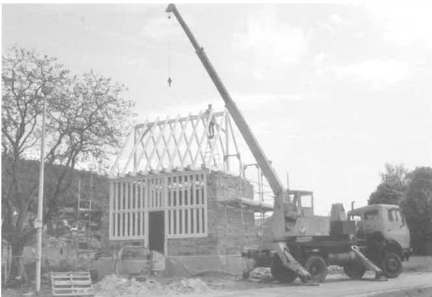
Fundamentlegung und Aufschlagen des Dachstuhles der neuen Hochkreuzkapelle im März und April des Jahres 2005.
